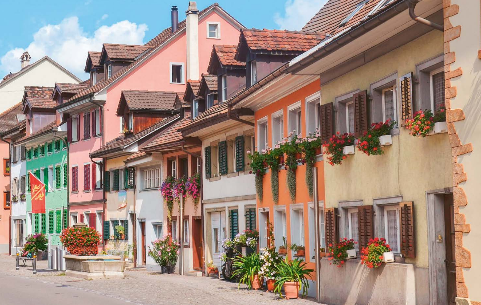
Häuserzeile in Diessenhofen: Über Dach, Fenster und Aussenwände geht bei Gebäuden am meisten Energie verloren.
