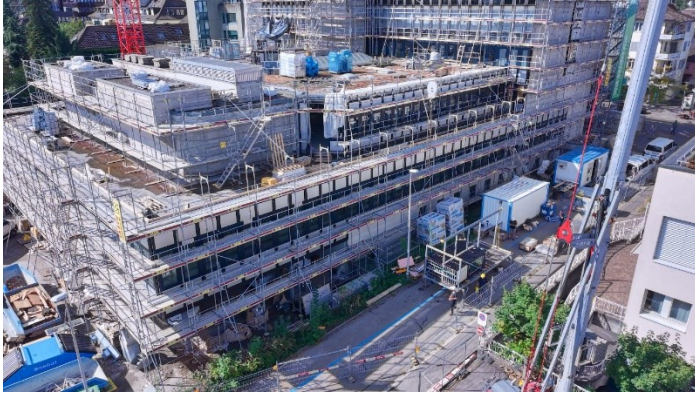
Nord-Ost-Ansicht der Fassade des TKB-Gebäudes in Kreuzlingen: Die Fassade wird nach den Grundsätzen der Kreislaufwirtschaft erneuert.
