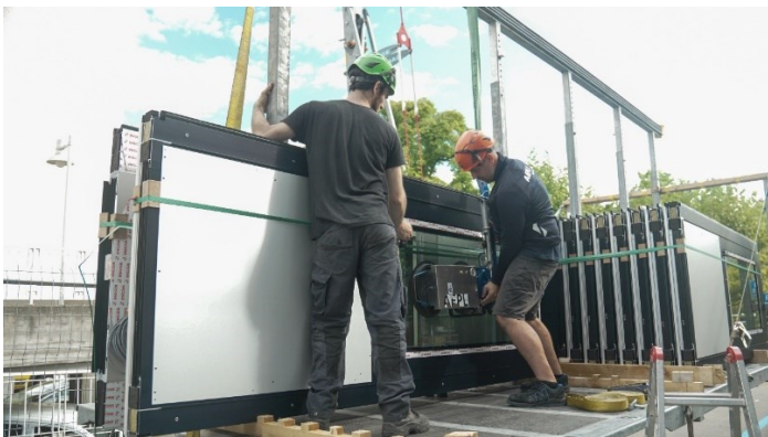
Die neuen Fassadenteile kurz vor der Montage: Sie bestehen zu fast 100 Prozent aus recyceltem Material.
